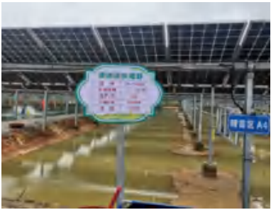
图 58：玉柴桂平农光互补光伏发电二期项目 - 光伏组件支架下养殖虾苗 39
