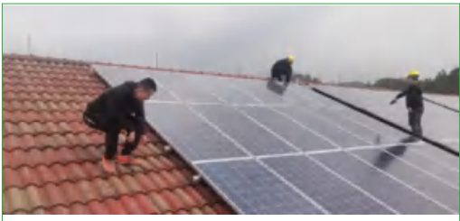
图 119: 安装屋顶光伏，供图：清华大学“每人一千瓦”项目组
