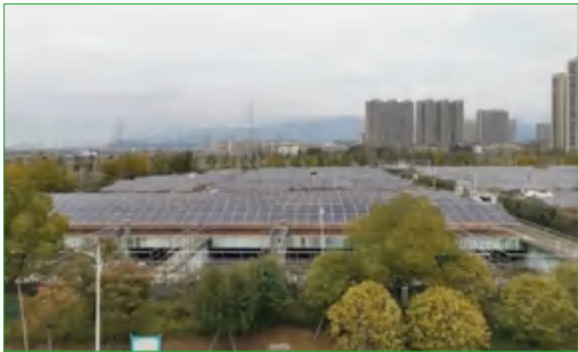
图 130: 石林彝族自治县人工湿地生态氧化塘太阳能发电微循环装置，供图：清华大学“每人一千瓦”项目组
