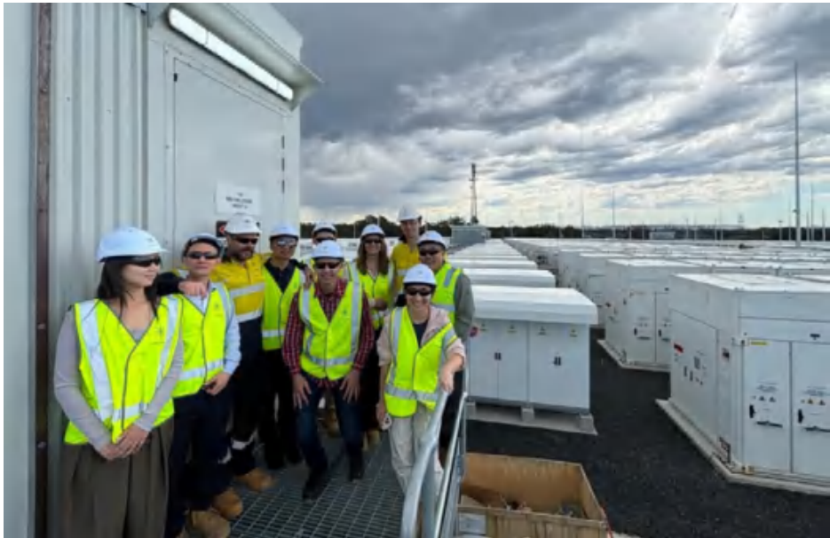
图 107: 澳大利亚 Waratah Super Battery Site 不仅是南半球规模最大的电池项目，也是目前世界上功率最大的电池项目之一。该电池储能系统坐落于悉尼以北约 100km 处，旨在提升澳大利亚新南威尔士州电网的可靠性，确保在该州从燃煤发电向清洁能源转型期间电网的稳定性。据悉，该项目占地 138,000m 2 ，项目设计达 850MW/1680MWh，瑞浦兰钧供给了其中超 70% 的电池。目前该项目正处于调试阶段。 74
