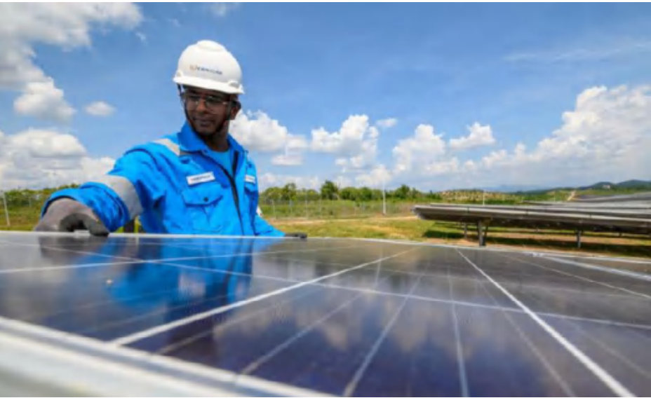
图 105: 马来西亚吉打州瓜拉基蒂光伏电站, 该项目由中国广核能源国际控股有限公司所属埃德拉电力控股有限公司运营, 由中国能源建设集团天津电力建设有限公司承建, 占地 260 英亩, 装机 50 兆瓦, 2019 年开始商业运行。摄影: 张纹综 71
