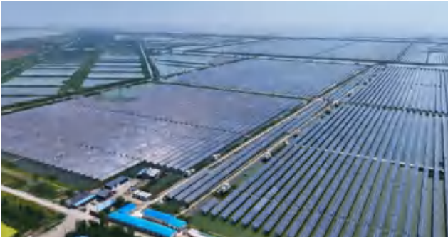
图 67：如东“光氢储一体化”40 万千瓦光伏项目，配套建设 60 兆瓦 /120 兆瓦时储能站、制氢能力 1500 标方 / 小时及加氢能力 500 公斤 / 天的制氢加氢站。摄影：绿色江南
